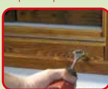
**Forare** il telaio della finestra con una punta con diametro 13 mm.
