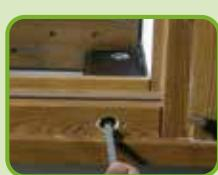
**Inserire** la barra quadrata all'interno del meccanismo attraverso il telaio della finestra.
