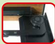
**Aprire** la persiana a 180° verificando il corretto movimento di apri/chiudi e bloccare con chiave le viti sottostanti il braccetto.
